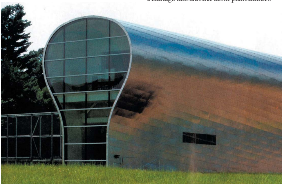
Tekniska anläggningar kan ges god gestaltning. Här ex av VA-anläggning i Hamden, Connecticut. Arkitekter S Holl & M van Valkenburg, Architecture oct -05.
