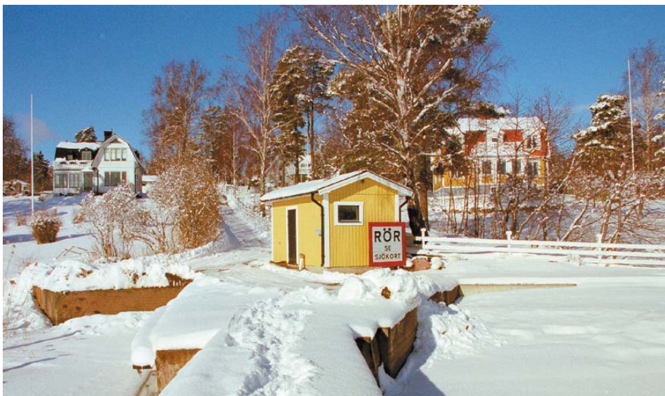
En mindre anläggning i form av pumpstation/reningsverk i Nantes.
